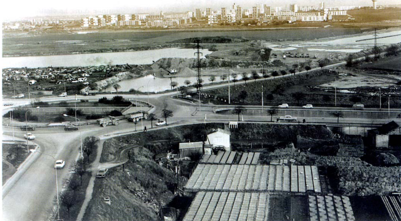
Vue sur le Mont-Mesly depuis le carrefour Pompadour.
