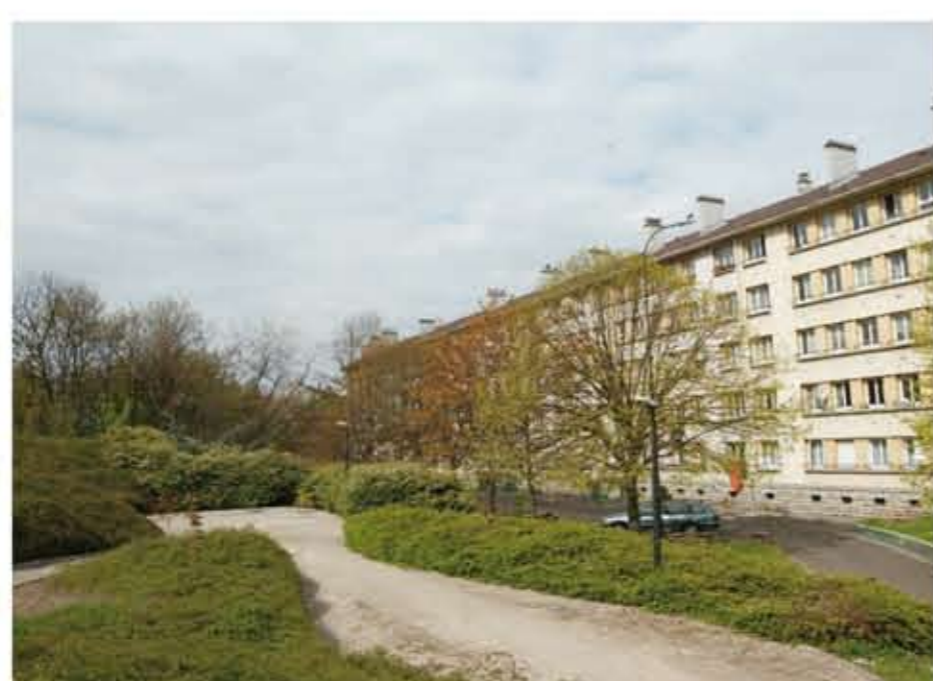
Vue depuis la voie Express
