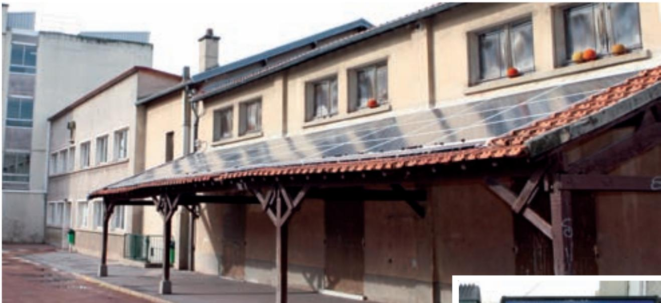
C'est à l'occasion de la réfection des toitures qu'a été décidée la pose de 800 panneaux solaires.
